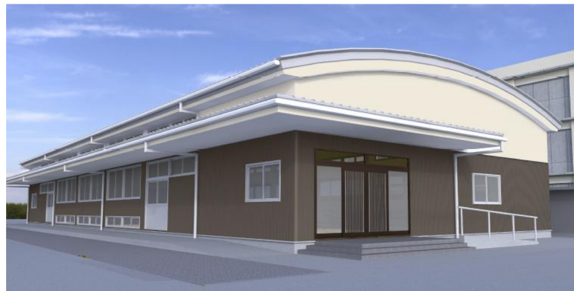
武道場「至道館」2023年春竣工
